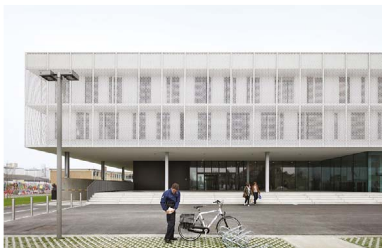
Politiecommissariaat Brugge © Filip Dujardin
